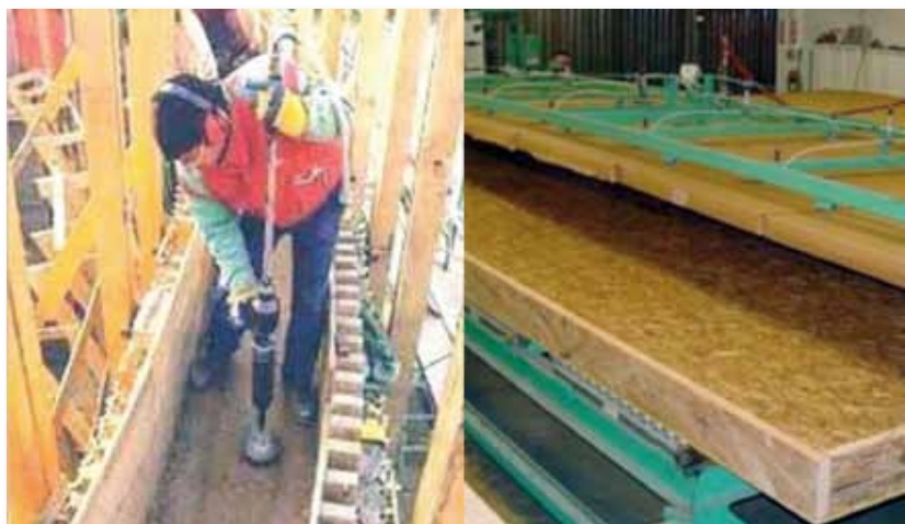
Tierra y Paja en la contemporaneidad. En los últimos años han sido numerosas las investigaciones y el desarrollo de nuevos sistemas de aplicación de los materiales tradicionales. El diseño de encofrados y pistones mecánicos para la optimización de la ejecución del tapial. Realización de paneles estructurales de paja prensada de gran formato. Imagen de ejecución Conzialtziön Kapelle de Berlín de Martin Rauch, 2002 Paneles estructurales en paja prensada de empresa estadounidense, 2005.
